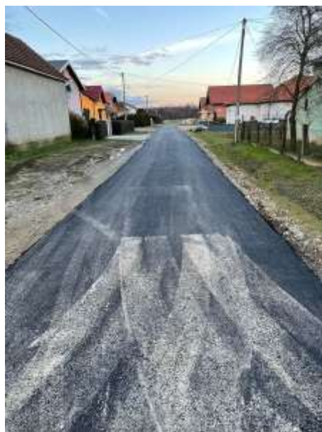
Slika 12: Postava finog sloja asfalta kroz sve ceste na kojima se izvodila aglomeracija – naselje Vratišinec
