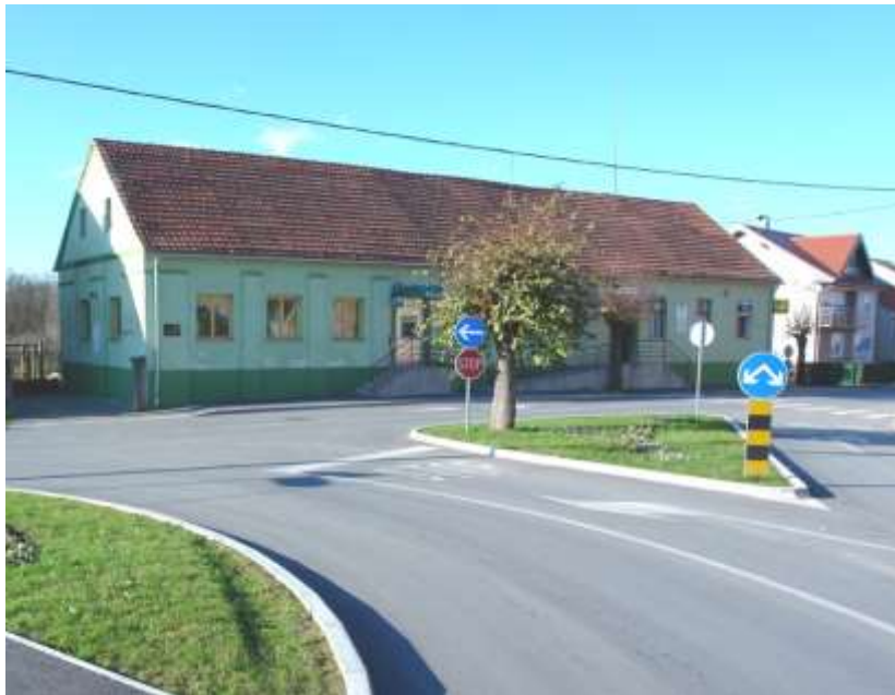
Slika 16: Obnova zgrade stare škole putem Ministarstva kulture + izgradnja memorijalnog centra Dr. Vinka Žganca
