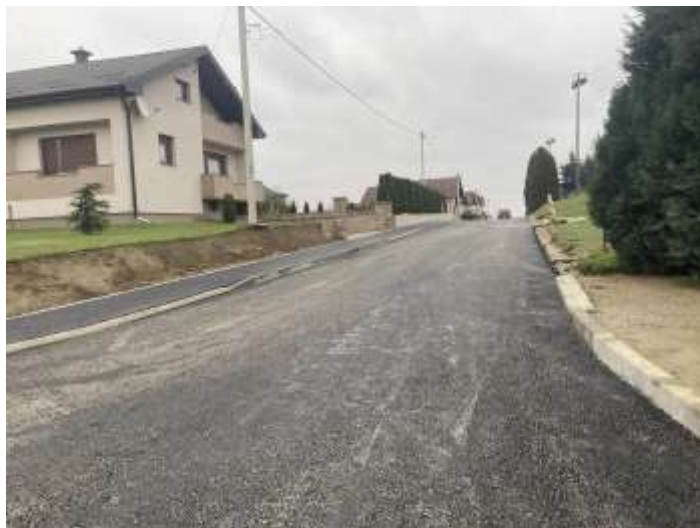
Slika 13: Školska ulica u Vratišincu – nastavak izgradnje pješačke staze i proširenje ceste
