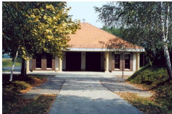
Slika 30: Grobna kuća u Vratišincu
